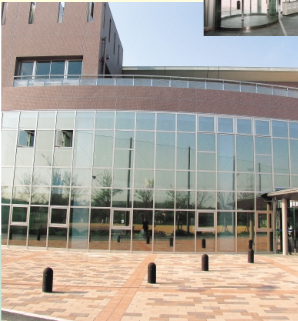
新学舎学生ホールの外観 (5ページに関連記事)
