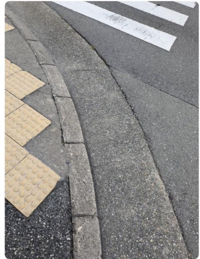
歩道と車道の段差がある所が多数あり、前輪を上げての操作がしにくい所があった。
